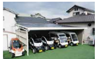
T・プラン(株)による充電ステーション・青空コンセント2
