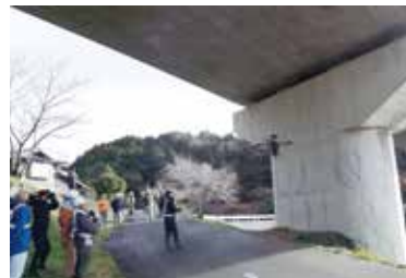
ドローンによる橋梁点検の様子
